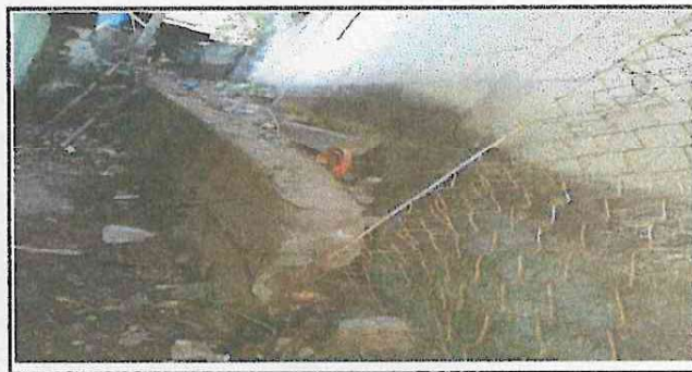
Foto 6: Reparación de muro perimetral de block con tubo hg y malla galvanizada
